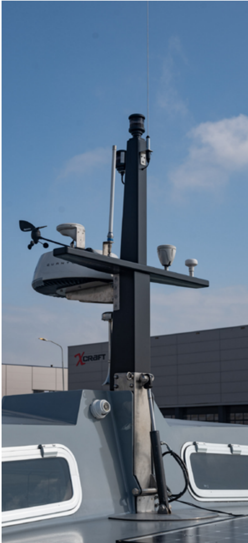
Nieuwe compacte mast
